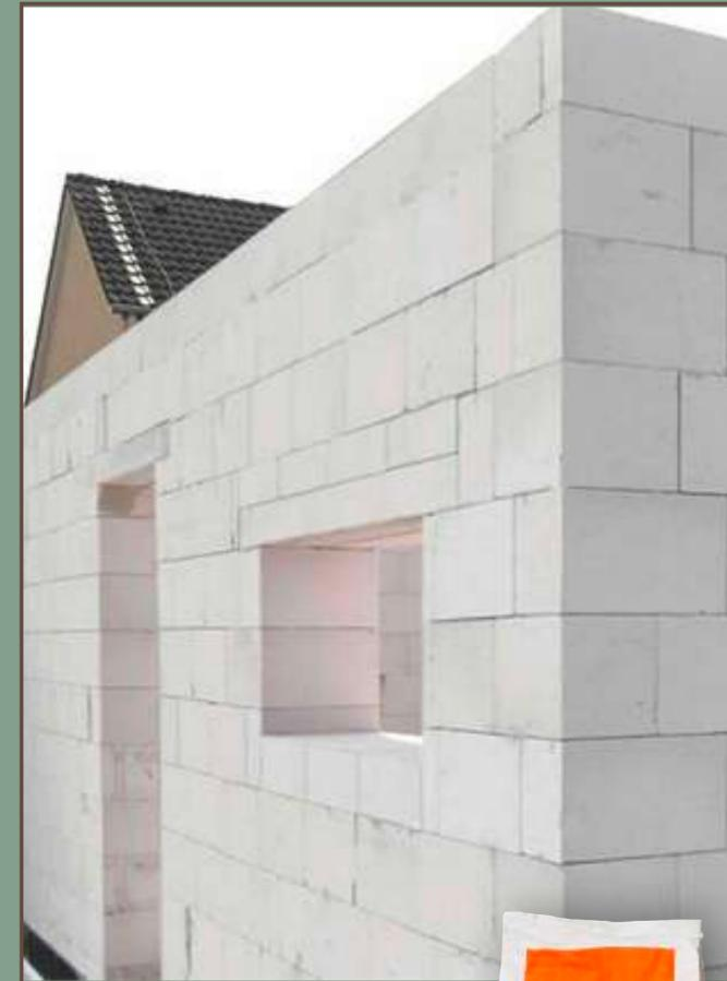
**Muros interiores de material aligerado asentados con Mortero HEBEL®.**
