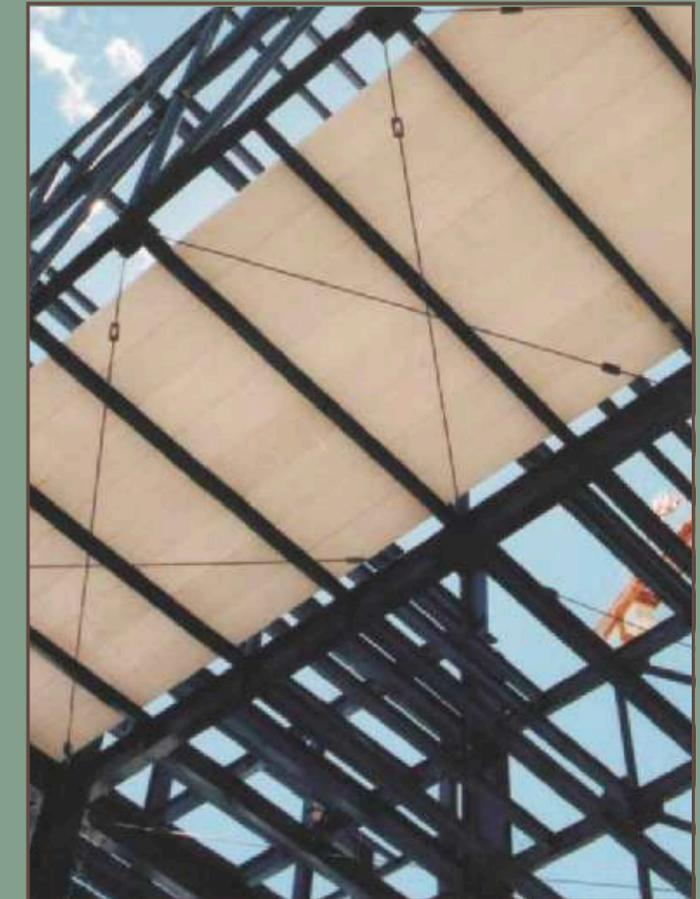
**Losa de entrepiso y azotea a base de vigueta y bovedilla del sistema HEBEL®.**
