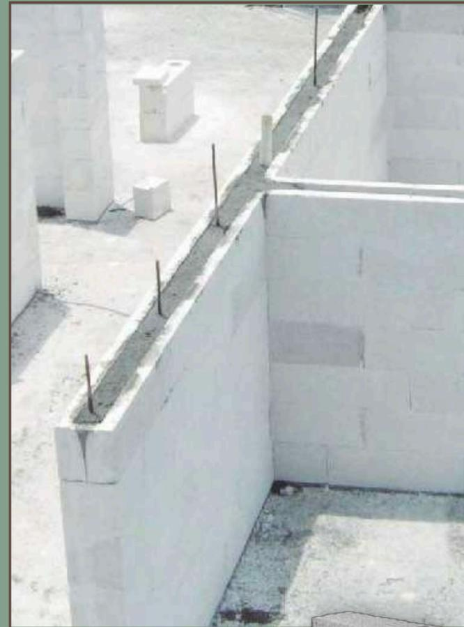
**Muros exteriores de mampostería reforzada HEBEL®.**
